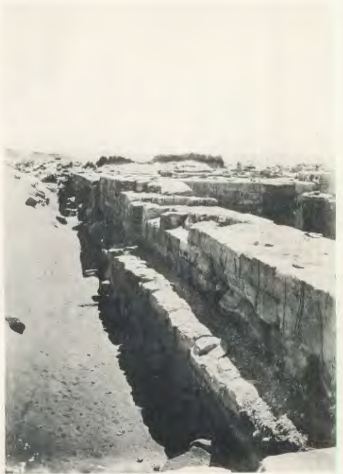
b. N. wall from N. tower of Pylon
