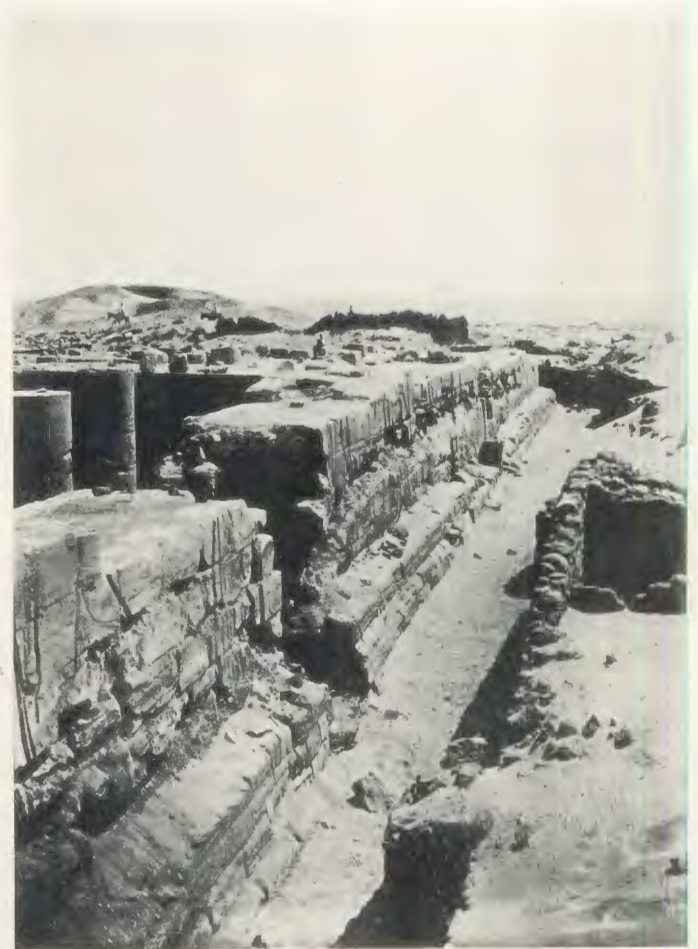
e. S. wall from S. tower of Pylon
